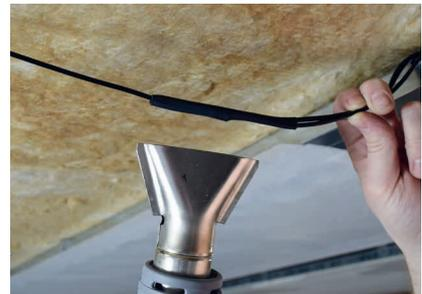
Schrumpfschlauch mittig über Pressverbindung ziehen und mit Heißluftföhn schrumpfen.
