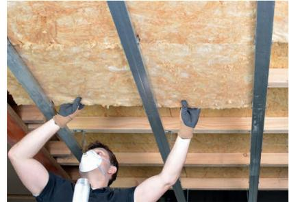
Dämmung z. B. Mineralwolle auflegen. Nur Dämmstoffe ohne Aluminiumkaschierung verwenden.
