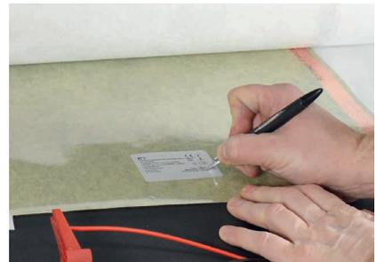
Widerstände zugeschnittener Folien erneut messen und auf Etikett sowie im Prüfprotokoll dokumentieren – Sollwerte der Montageanleitung entnehmen.
