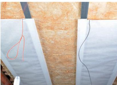
Der elektrisch aktive Heizbereich (410 mm) ist stets mit einem Abstand von je 10 mm zu jeder Seite zwischen den Trockenbauprofilen auszurichten.
