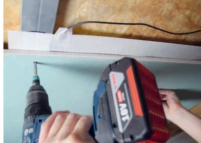
Trockenbauplatte (max. Stärke 12,5 mm) gemäß Herstellerangaben montieren.
