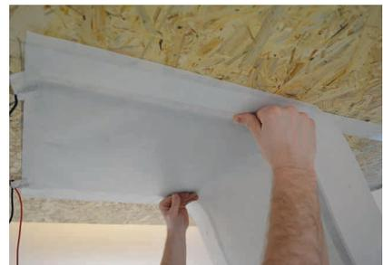
Heizfolie am Montagestreifen z.B. mit doppelseitigen Klebeband oder Tackernadeln an Unterdeckplatte befestigen
