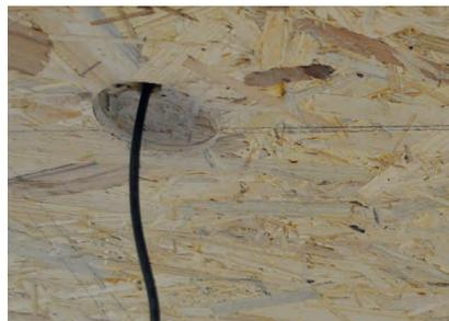
Aussparung für den Folienkontakt erstellen und Zuleitungen verlegen.
