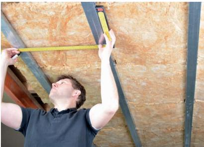
Zum parallelen Ausrichten der Heizfolien sind senkrecht zu den Profilen Markierungen anzubringen.
