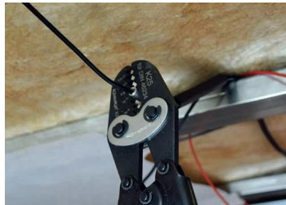
Universalverbinder mittig mit Presszange für Quetschverbinder nach DIN 46341-1, Forma A verpressen (z. B. Presswerkzeug Klauke K25).
