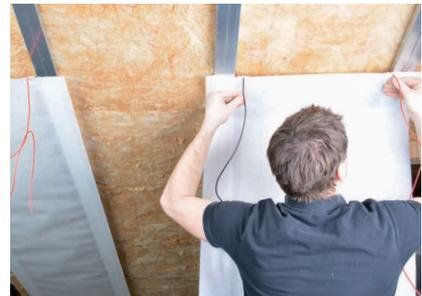
Heizfolie ohne Knicke und Falten am Montagestreifen befestigen. Die durchsichtige PET-Beschichtung zeigt nach oben zum Profil.
