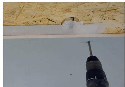
Trockenbauplatten (max. Stärke 12,5 mm) außerhalb des elektrisch aktiven Heizbereichs (410 mm) z. B. im Montagestreifen gemäß Herstellerangaben befestigen.
