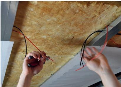
Leitungsenden verdrehen und in Universalverbinder einführen. Querschnitte der Leitungen und des Universalverbinders beachten.
